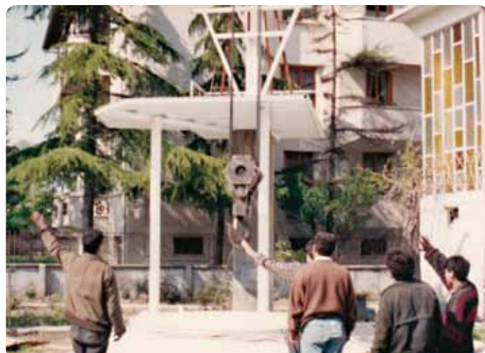
■ A darú helyére emeli a tányérantennát.
